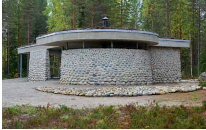
Rakennus on nimeltään Öykkösenvaaran sotahistoriallisen alueen yleisötila.
