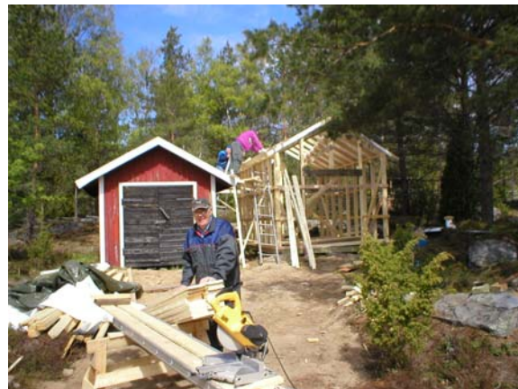
Rakennus harjakorkeudessa, etualalla Muinan talkoomies katkaisemassa seinälautoja
