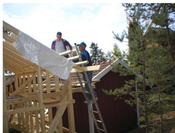
Olli ja Pentti asentamassa aluskatetta ja ruodelautoja kattotiiliä varten
